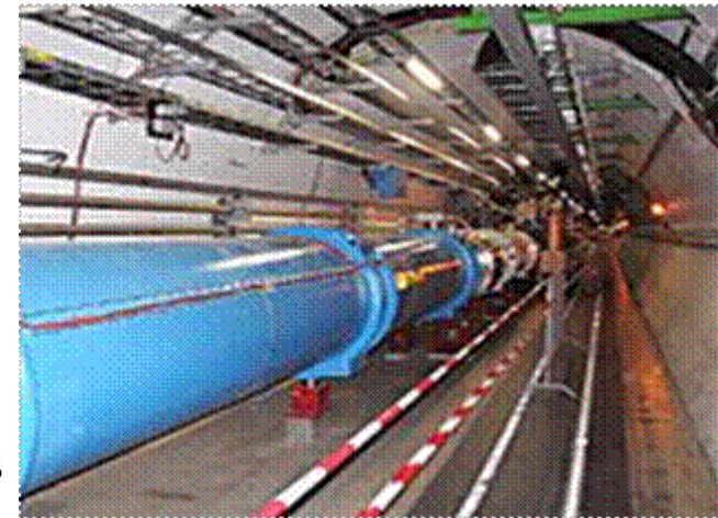
Tunnel du LHC avec tube contenant les électroaimants supraconducteurs
